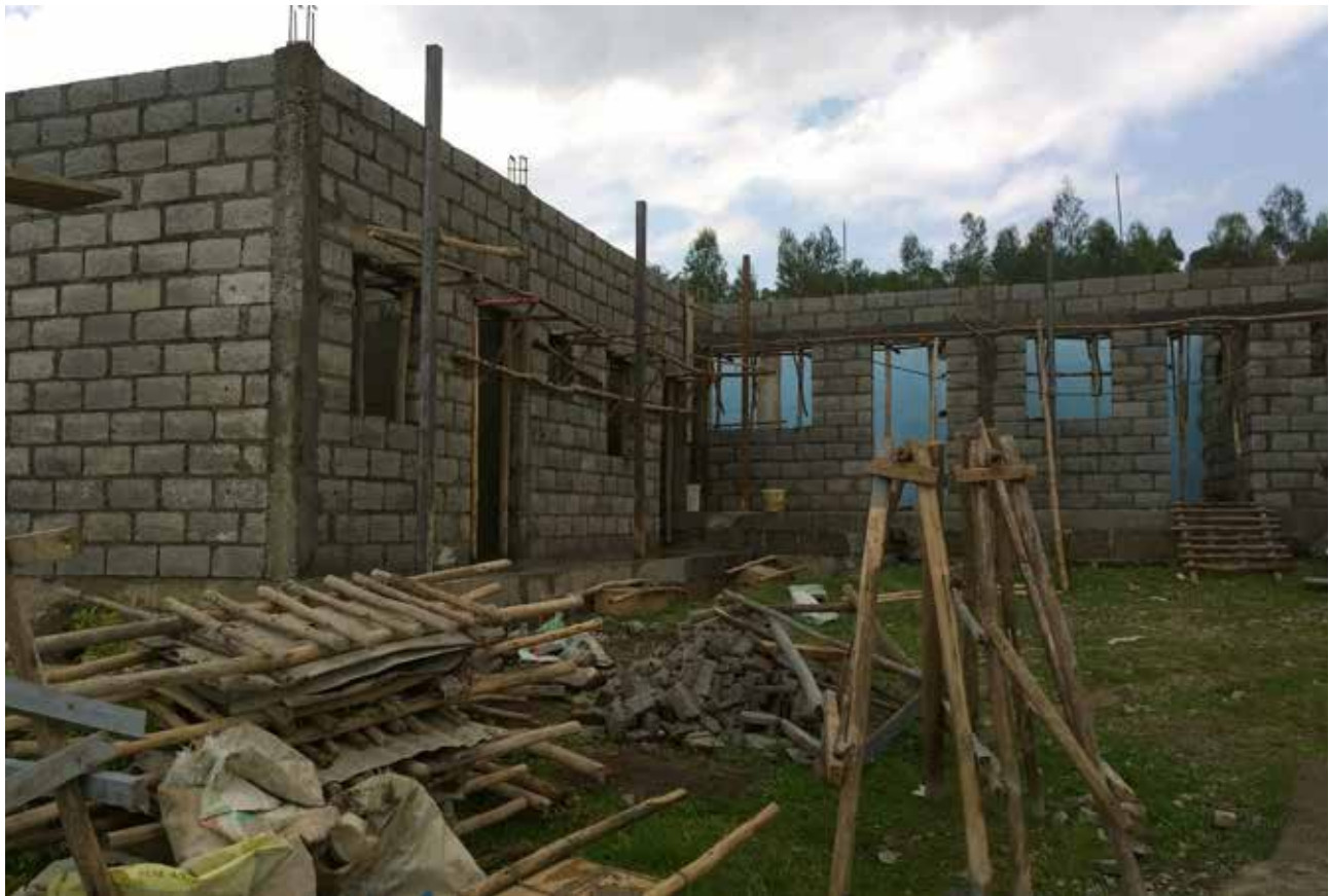
▲ Avanzamento dei lavori
