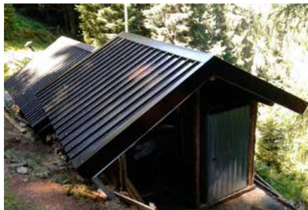
▲ Copertura del tetto
